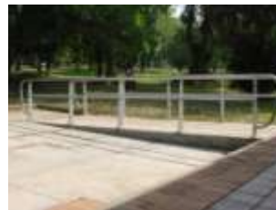
Construcción de rampas peatonales
