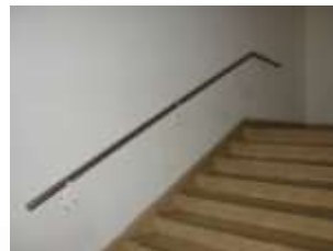
Instalación de pasamanos
